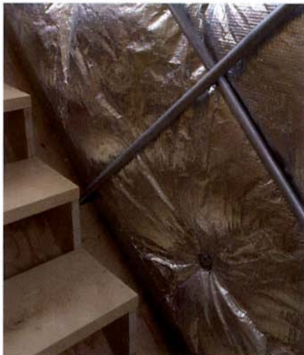
L'isolant a été laissé apparent pour se jouer des reflets et de la lumière. Il a été posé comme un capitonnage, protégé par des tirants métalliques.
