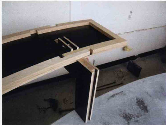
Implantés en périphérie, les bureaux ne sont pas démontables puisqu'ils forment garde-corps.
