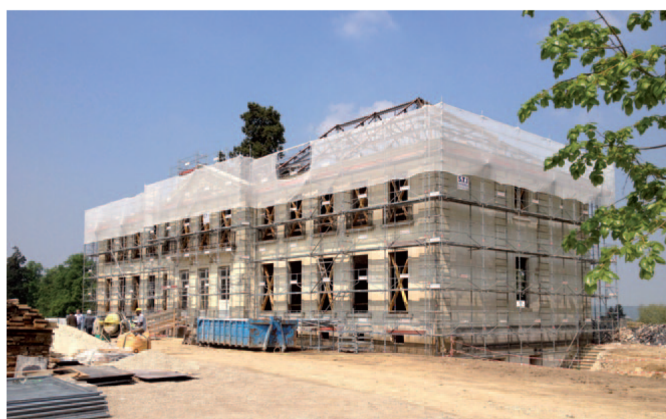
En haut : perspective de Vincent Germond réalisée lors du concours. À gauche : chantier de la rénovation.
